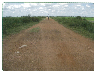
舗装後、きれいになった道路
